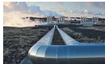
Рис. 12. Теплоснабжение столицы Исландии Рейкьявика полностью осуществляется от геотермальной станции, расположенной в 7 км от города
