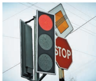
Рис. 9.3. Сигналы современных светофоров хорошо заметны даже при ярком солнце. В таких светофорах лампы накаливания заменены светодиодами
