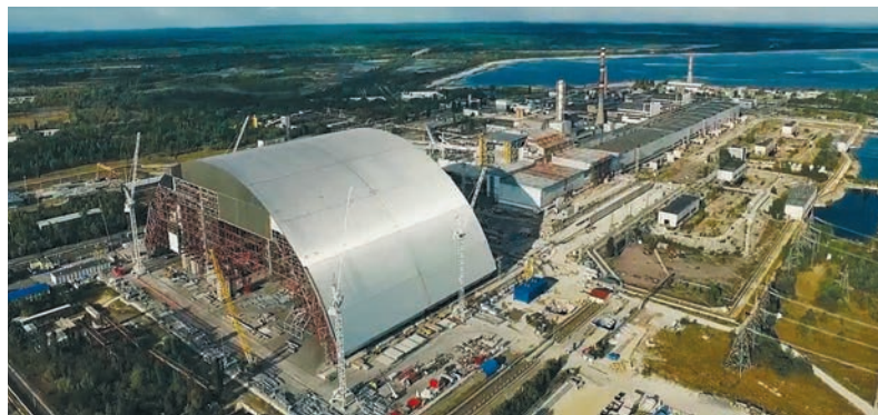
Рис. 27.8. Саркофаг над 4-м энергоблоком Чернобыльской АЭС
